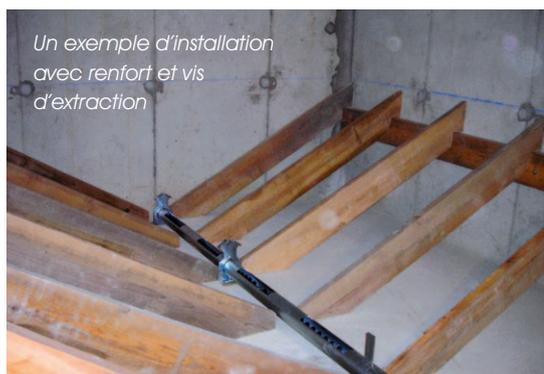
Un exemple d'installation avec renfort et vis d'extraction
